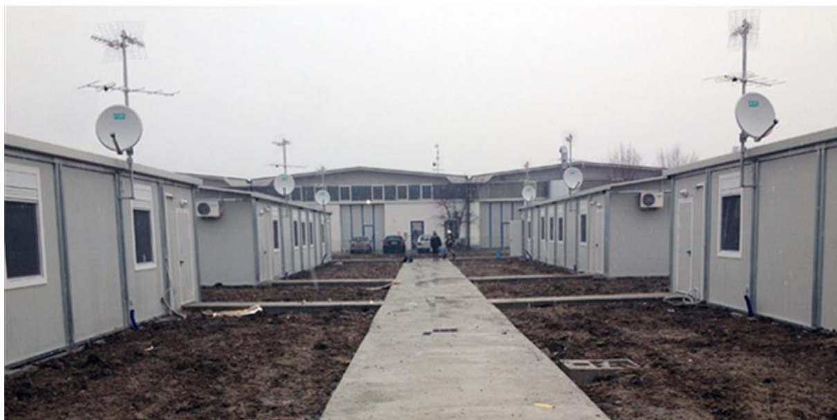
Figura 42– Esempio di prefabbricati modulari abitativi rimovibili. Novi di Modena e Rovereto di Novi (MO)
